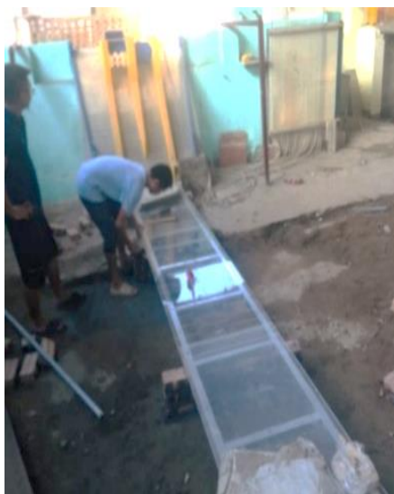
Hình 2.14 Lắp đặt, cân chỉnh đáy kênh dẫn đảm bảo đáy phẳng
