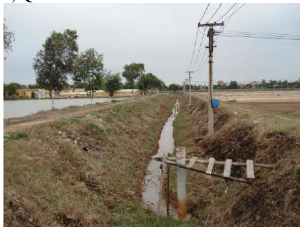
Hình 2: Hệ thống mương cấp, thoát nước vào các ao nuôi tôm.
