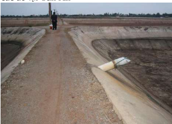
Hình 8: Hệ thống thoát nước nuôi tôm tại các ao tại Tân An
