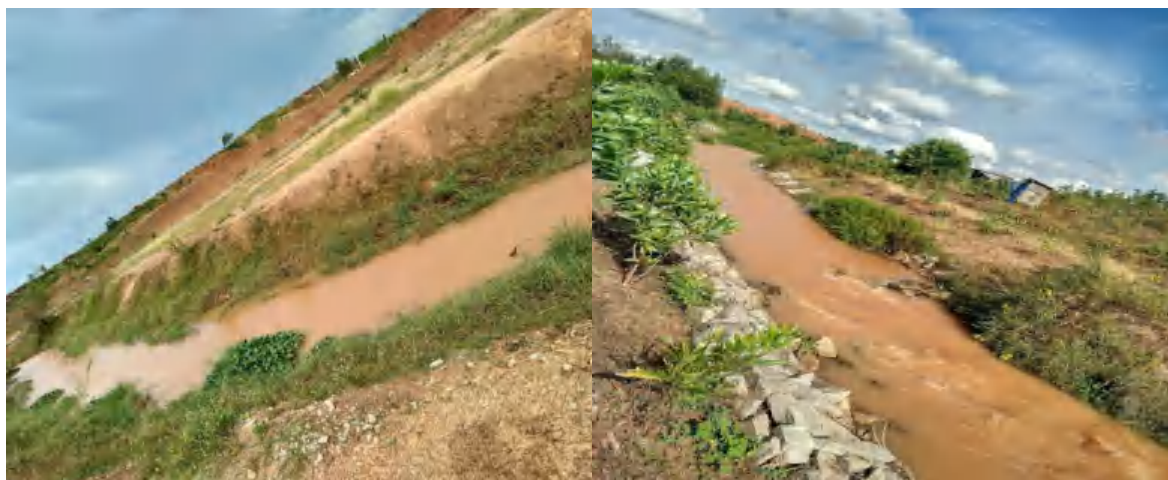
Hình 3.8. Đoạn kênh đất không lót đá cuội (bên trái) và đoạn kênh đất lót đá cuội (bên phải) trên khu vực ĐDCQĐ III (tháng 7/2017)
