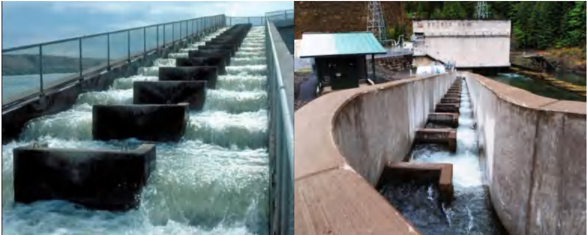
Hình 1.8. ĐDCQĐ "Ice Harbor" (bên trái) và "Half Ice Harbor" (bên phải) (Nguồn: Beckwith và nnk, 2013 [31])
