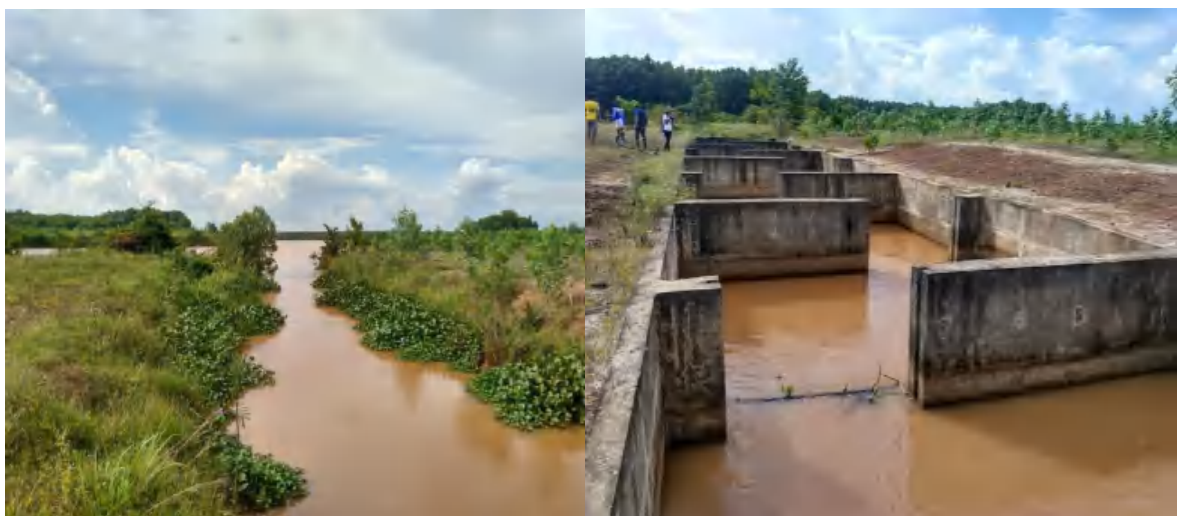
Hình 2.2. Cửa vào/ra ĐDCQĐ phía thượng lưu (bên trái) và đoạn kênh bê-tông được thiết kế theo loại hình "khe dọc thẳng đứng" (tháng 7/2017)
