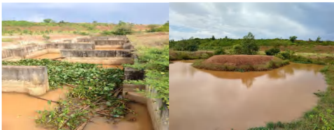
Hình 3.6. Đoạn thiết kế theo loại hình ĐDCQĐ "khe dọc thẳng đứng" và hồ nghỉ cho cá tôm ở khu vực ĐDCQĐ I (tháng 7/2017)
