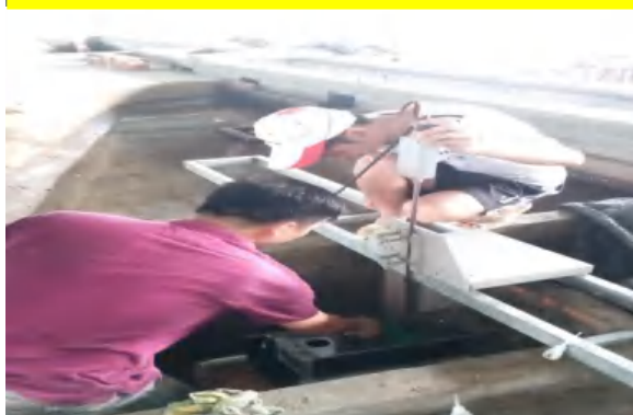
Lắp ráp thiết bị thủy lực thử nghiệm
