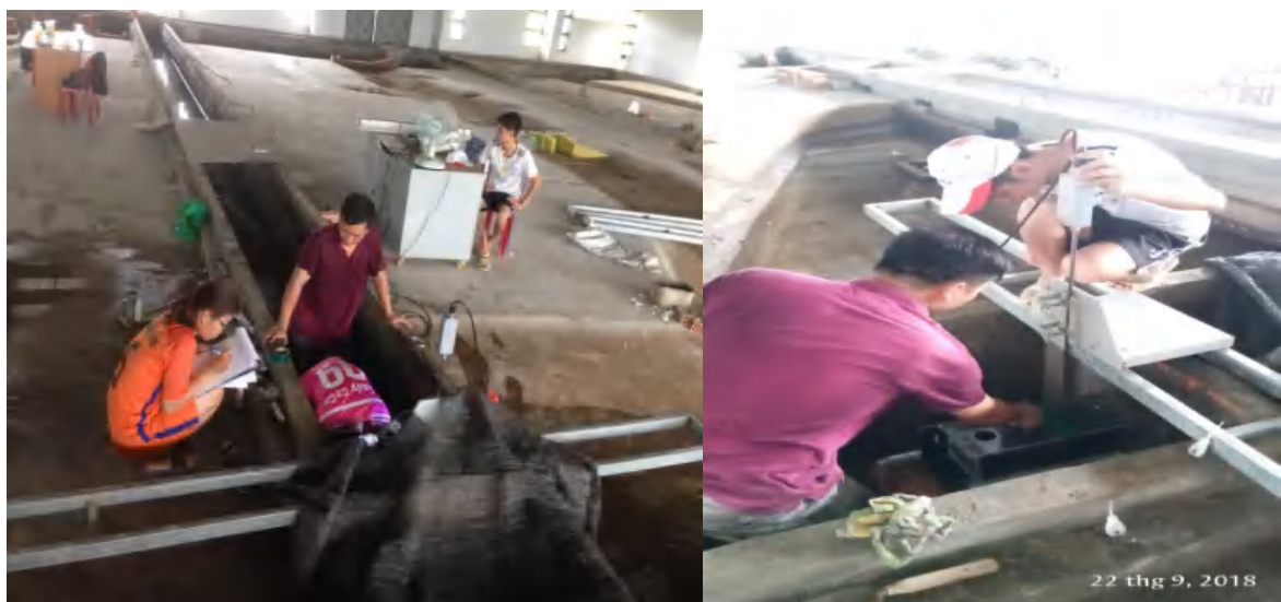
Hình 2.14. Quá trình chuẩn bị và thực hiện thử nghiệm với thiết bị thủy lực
