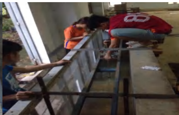
Lắp ráp Hệ thống đo lưu tốc nước
