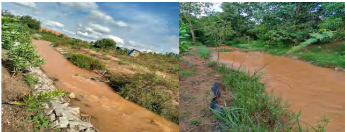
Hình 2.4. Đoạn kênh đất được lát đá cuội (bên trái; tháng 7/2018) và kênh đất không được lát đá cuội (bên phải; tháng 11/2017)
