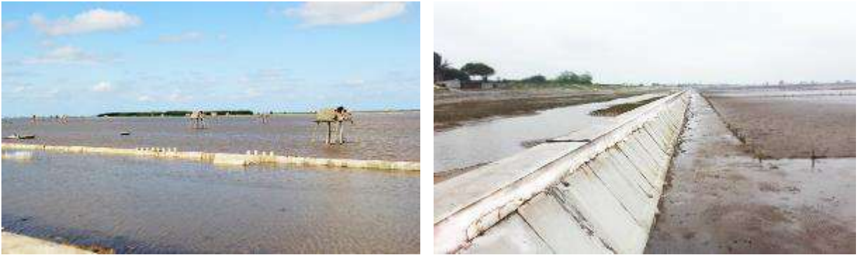
Hình 1-7. Kè lắp ghép bảo vệ bờ biển Tiên Hải, Thái Bình
