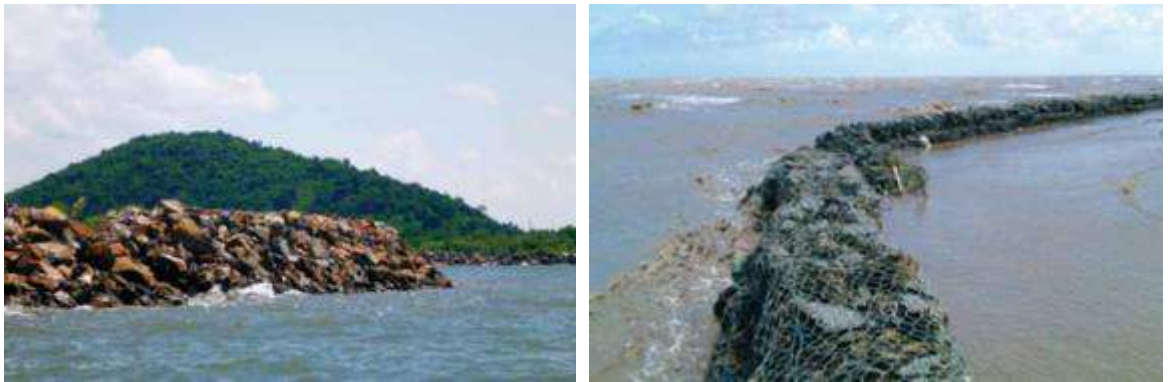
Hình 1-23. Đê chắn sóng bằng đá đổ tại Kiên Giang (Trái) và Cà Mau (Phải)
