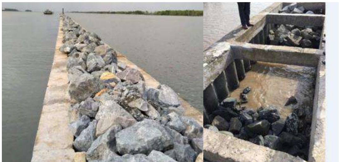
Hình 1-26. Kè bê tông ly tâm đổ đá hộc tại tỉnh Cà Mau
