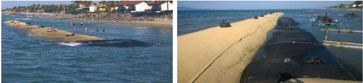
Hình 1-6. ĐGS dạng ống vải mới được thi công tại ven biển Cửa Đại
