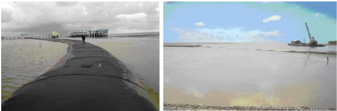
Hình 1-20. ĐGS dạng ống Geotube tại ven biển Bạc Liêu
