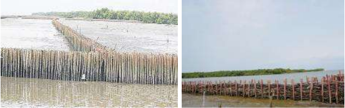
Hình 1-4. Mỏ hàn bằng cọc tre và gỗ ở Thái Lan
