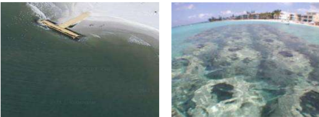
Hình 1-5. Mỏ hàn bằng Geotube và ĐGS ngầm bằng cấu kiện reefball tại Mỹ
