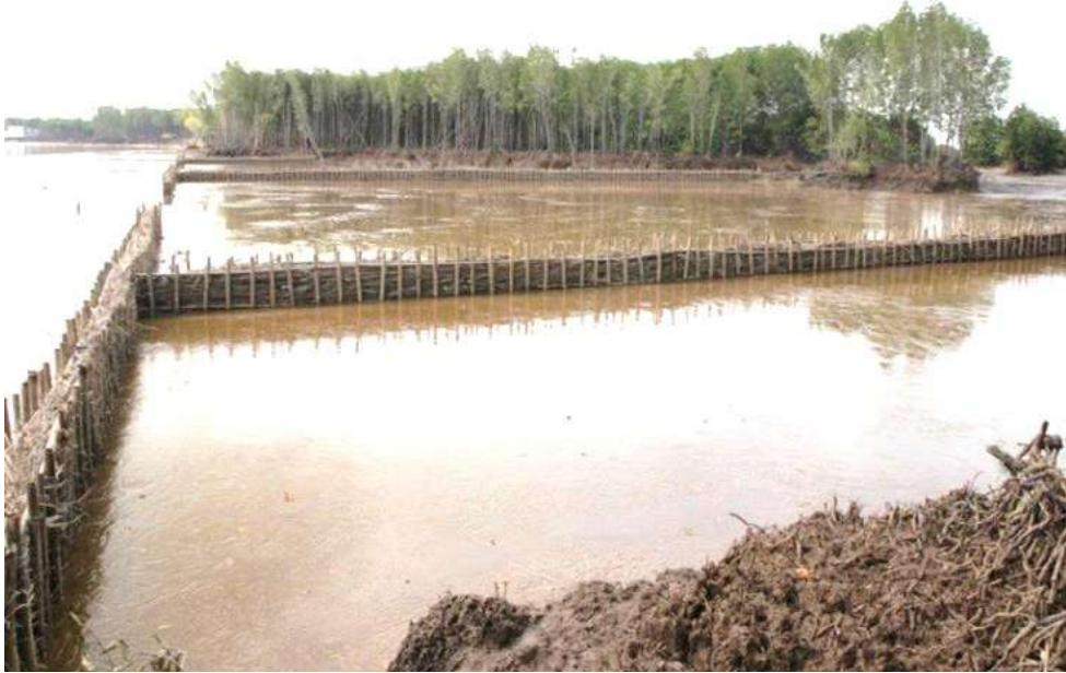
Hình 1-21. Kè chữ T bằng cọc tre do tổ chức GIZ xây dựng tại tỉnh Bạc Liêu
