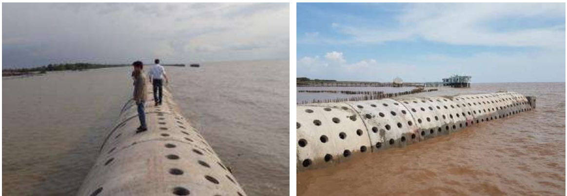
Hình 1-24. Đê trụ rỗng được áp dụng tại Cà Mau (trái) và Bạc Liêu (phải)
