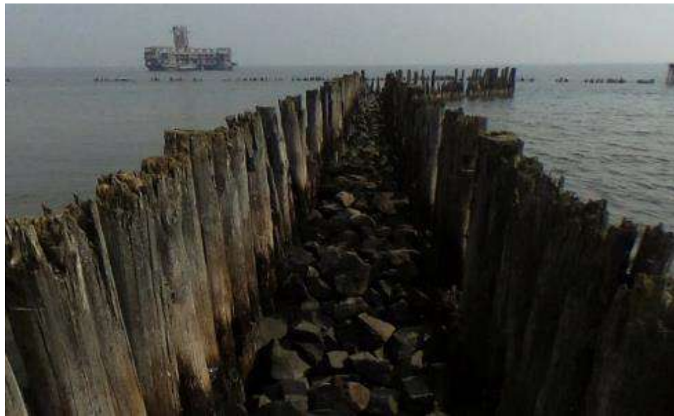
Hình 1-3. Mỏ hàn bằng cọc gỗ đổ đá tại bờ biển Baltic, Ba Lan
