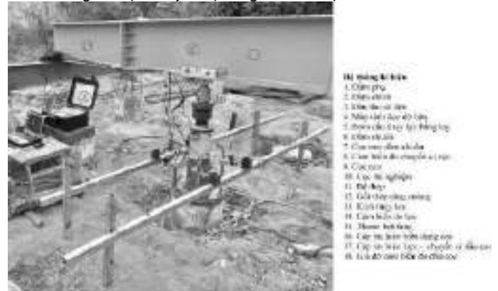
Hình 4. Hệ thống thí nghiệm nén tĩnh cọc
