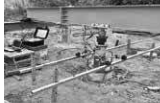
(c) Hiện trường công tác thí nghiệm nén tĩnh cọc
