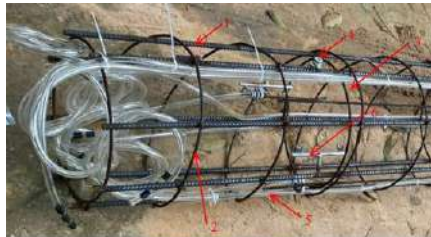
Hình 3.4. Khung thép cọc khoan nhồi được chế tạo tại xưởng
