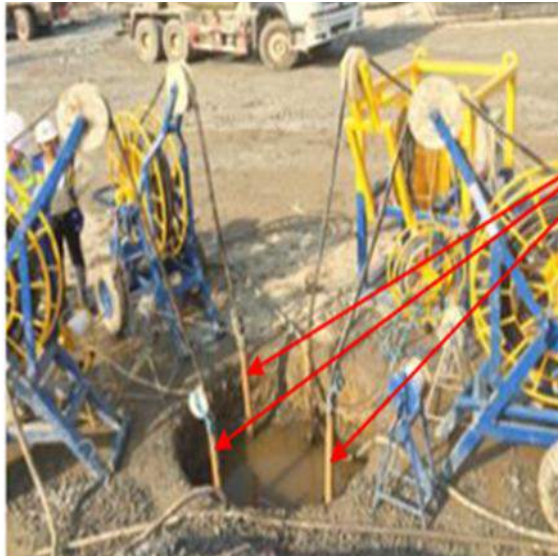
Hình 1.2. Thi công phụt vữa cho cọc khoan nhồi [21]
