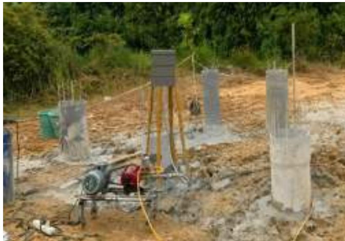
Hình 3.7. Quá trình phụt vữa
