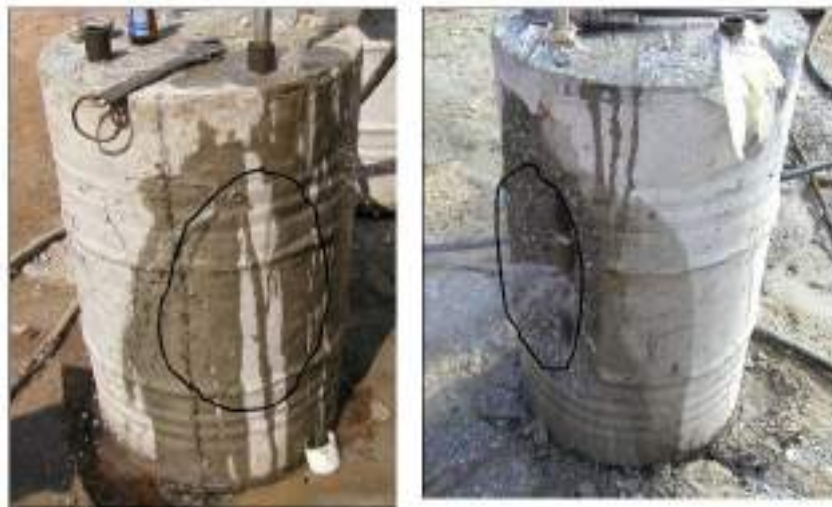
Hình 1.1. Thử nghiệm phá nước sau 24 giờ, 5 giờ thi công bê tông [42]
