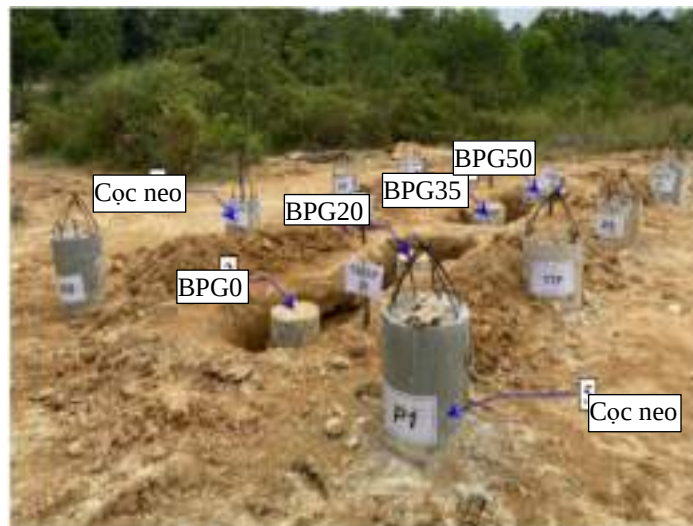
Hình 3.11. Hiện trường khu vực thí nghiệm sau khi hoàn tất thử tải tĩnh cọc
