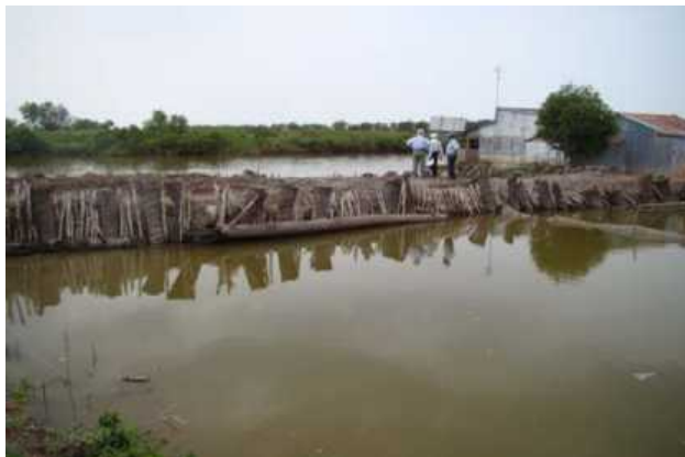
Hình 3: Đập thời vụ bằng đất trong thời gian ngắn hạn và khi phá dỡ
