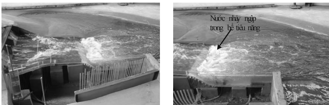
Hình 10: Phân bố dòng chảy trên dốc nước, bể tiêu năng và kênh xả hạ lưu- PA kiến nghị
