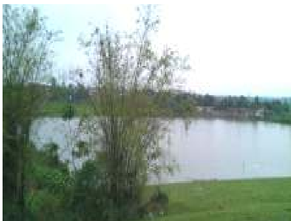
Hình 3.7 Ao phía hạ lưu đê
