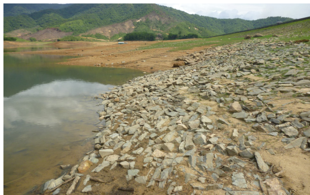
Hình 2. Hiện trạng đập đất
