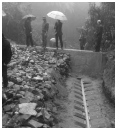
Hình 7. Công nghệ cấp nước kiểu đập ngầm
