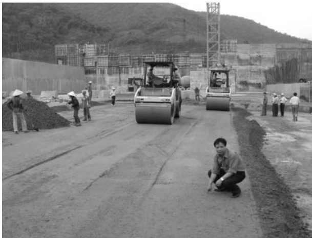
Hình 3. Công nghệ bê tông đầm lăn áp dụng cho hồ chứa nước Định Bình
