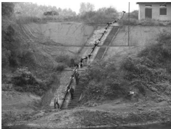
Hình 10. Bơm hút sâu với cột hút từ 6-8m, bơm trượt trên ray
