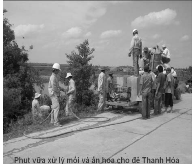
Hình 6. Xử lý môi cho đê, đập
