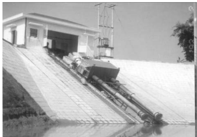
Hình 10. Bơm hút sâu với cột hút từ 6-8m, bơm trượt trên ray
