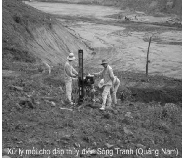
Hình 6. Xử lý môi cho đê, đập
