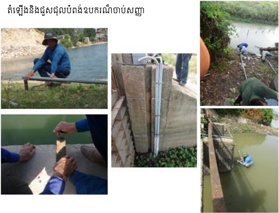
រូបភាព ១.១១ ការតំឡើងបំពង់និងឧបករណ៍កំរិតទឹក
