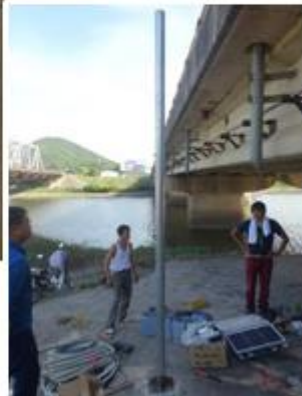
Gambar 1.5. Pemasangan pipa baja ke struktur beton dengan baut jangkar
