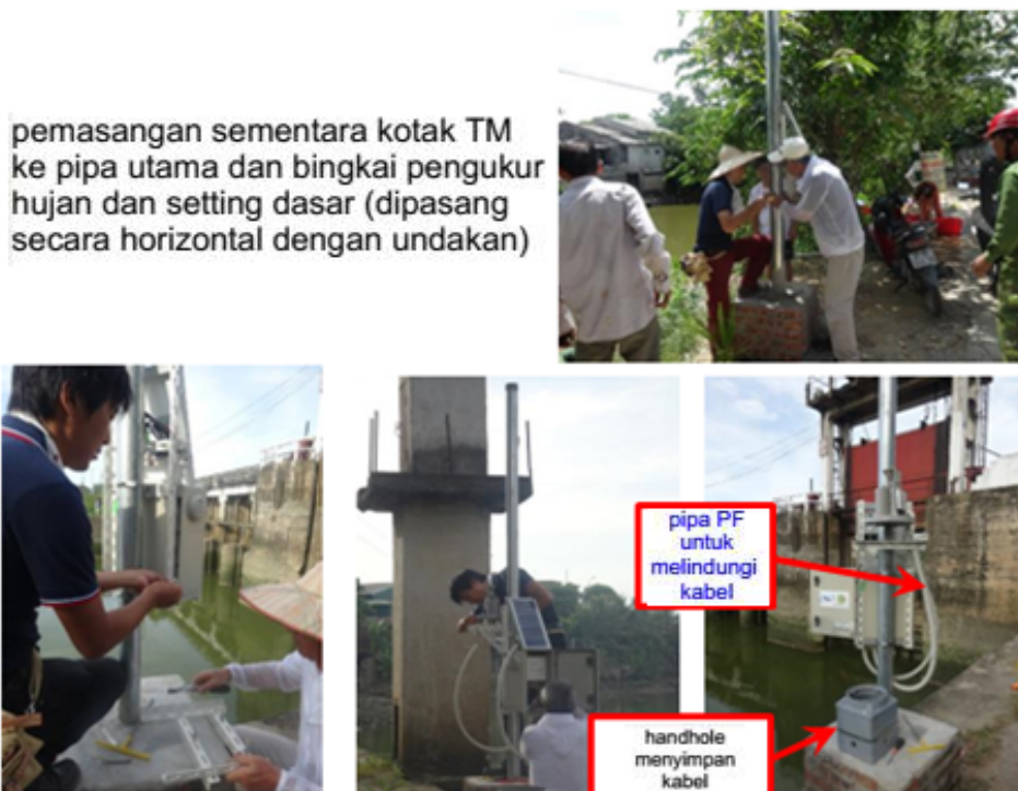
Gambar 1.7. Pemasangan sementara kotak kontrol TM, panel surya, dan lubang tangan
