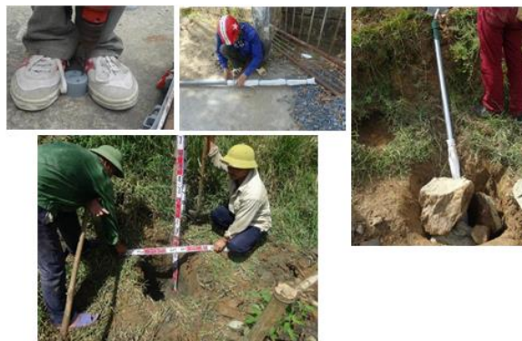
Gambar 1.10 Pengeboran pipa pelindung untuk sensor ketinggian air dan pelapisan bagian yang dibor dengan kain non woven
