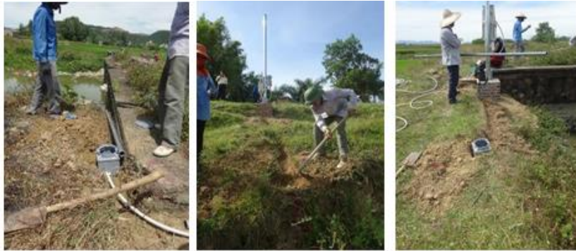
Gambar 1.8. Pemasangan kabel sensor level air
