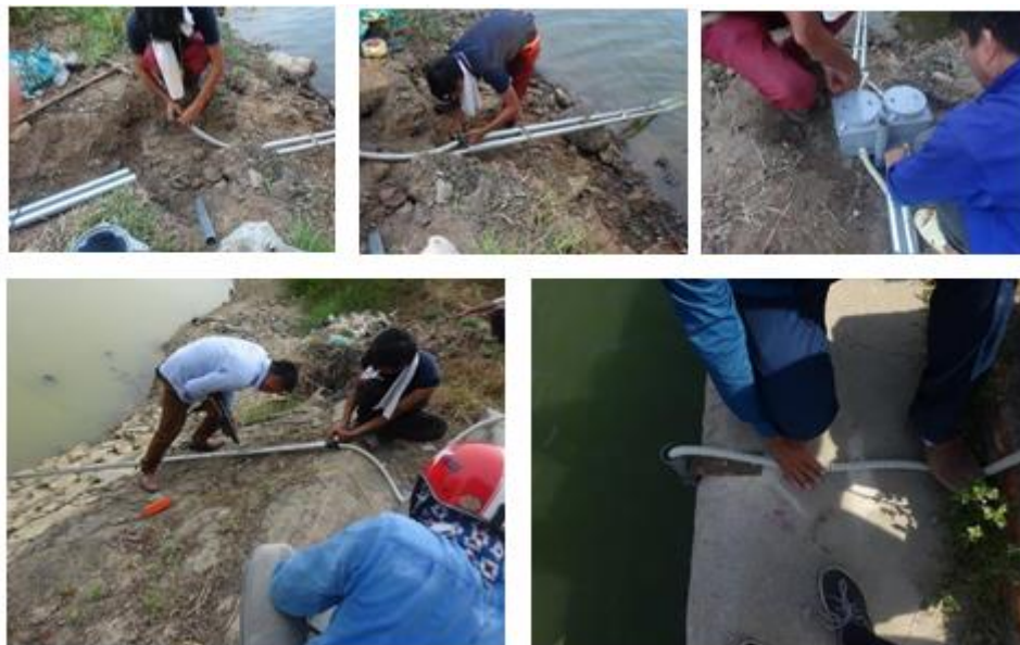
Menghubungkan pipa sensor, pipa PF, dan handhole
