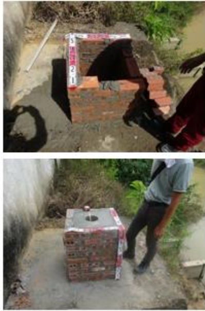
Gambar 1.4. pembangunan pondasi beton
