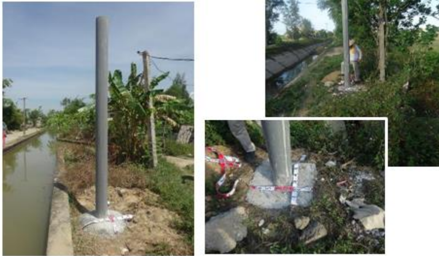
Gambar 1.6. Pemasangan tiang menggunakan pipa PVC D250mm sebagai bekisting di lokasi dengan risiko pencurian tinggi
