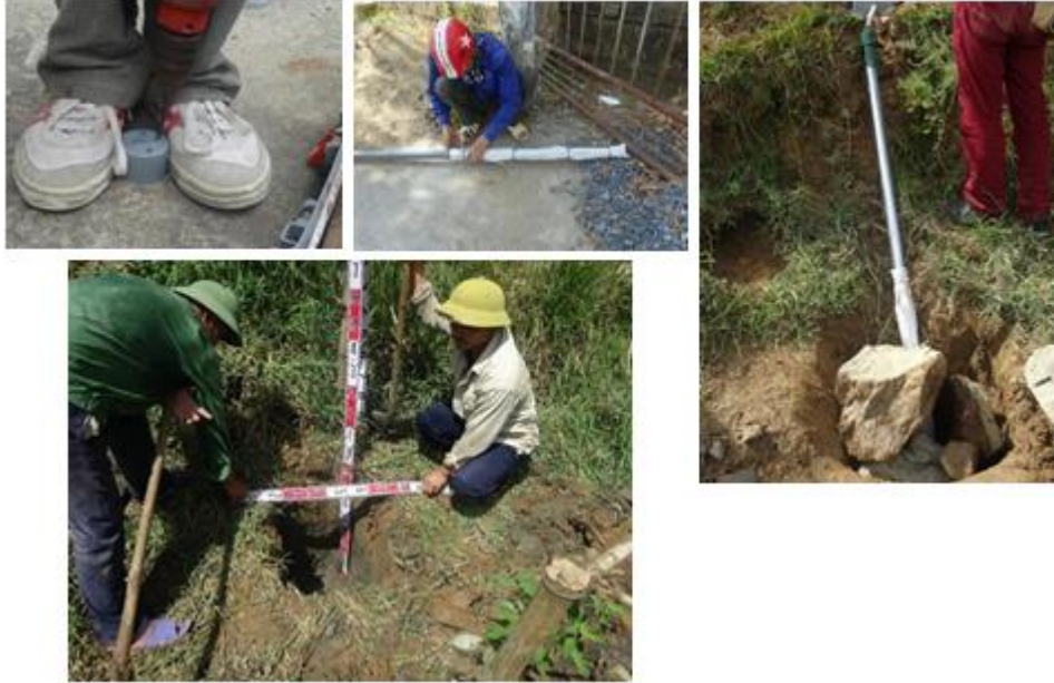
ပုံ 1.10 ရေပြင်အာရုံခံကိရိယာအတွက် အာရုံခံပိုက် တူးခြင်းနှင့် တူးဖော်မည့်ဘက်အခြမ်းတွင် အမျှင်မပါသော ပိတ်စဖြင့် ကာကွယ်ခြင်း
