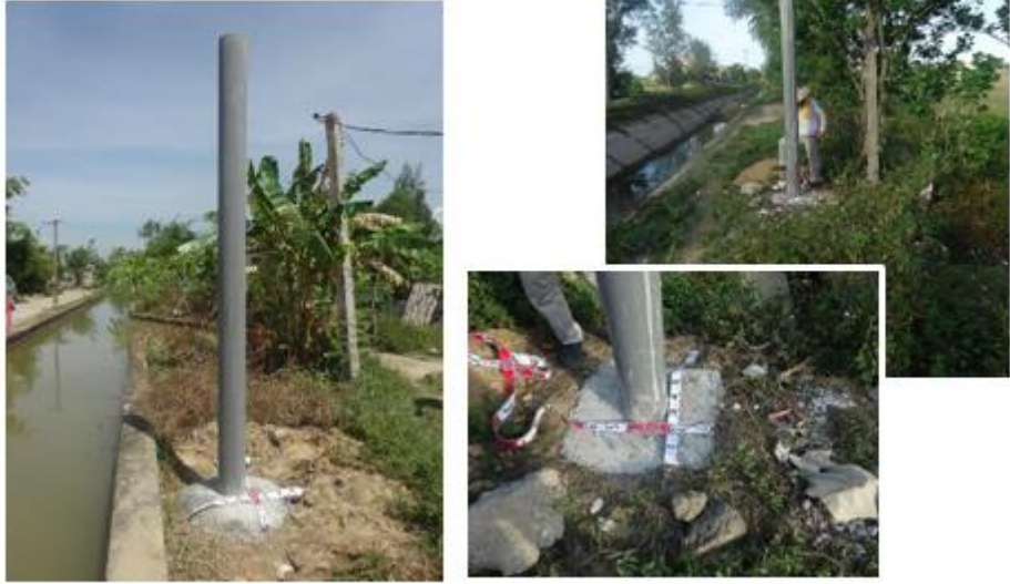
ပုံ 1.6 မိုးယူခံရနိုင်သော နေရာများတွင် အထိုင်အဖြစ် D250mm PVC ပိုက် အသုံးပြုပြီး အထောက်အပံ့တိုင် တပ်ဆင်ခြင်း
