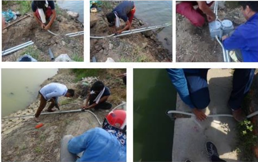
ပုံ 1.12. PF ပိုက်ဖွဲ့ရာအောက်အာရုံခံကိရိယာ cable ကိုကာကွယ်ခြင်း၊ လက်တွင်းပိုလျှံ cable ကို၏သိုလှောင်မှု
