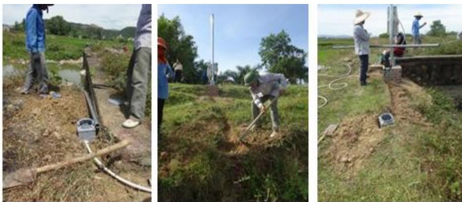
รูปที่ 1.8 การติดตั้งสายเคเบิลเซ็นเซอร์วัดระดับน้ำ
