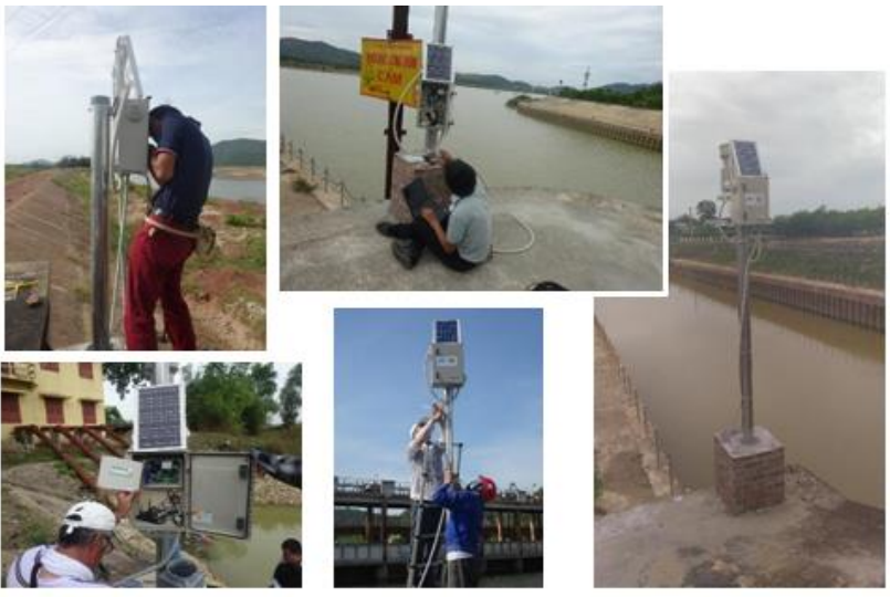
รูปที่ 1.13 การตั้งค่าเริ่มต้นของระบบการสื่อสารในกล่องควบคุมด้วยคอมพิวเตอร์ส่วนบุคคลและการทำงานให้เสร็จสมบูรณ์การงาน
