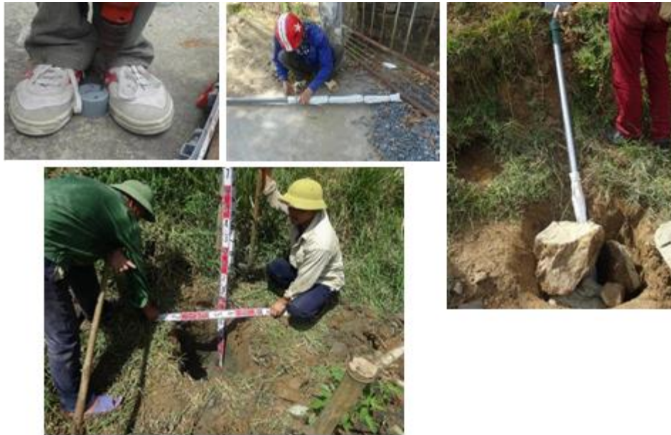
รูปที่ 1.10 ท่อนำทางเจาะแสดงเซ็นเซอร์ระดับน้ำและปกป้องคลองที่เจาะด้วยผ้าไมทอ
