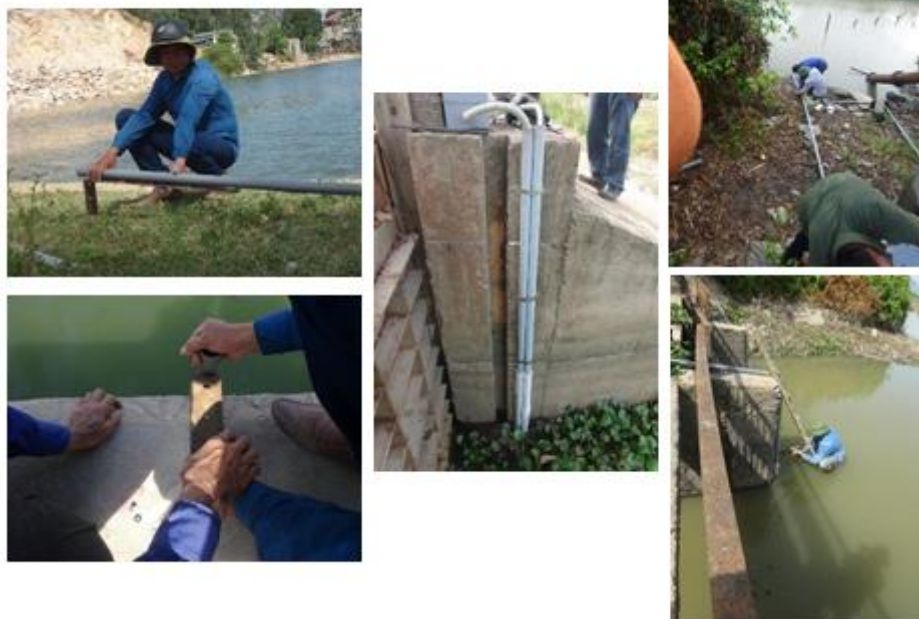
รูปที่ 1.11 การติดตั้งท่อนำทิศและเซ็นเซอร์ระดับน้ำ
