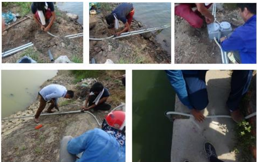
รูปที่ 1.12 การป้องกันสายเซ็นเซอร์ระดับน้ำโดย PF
