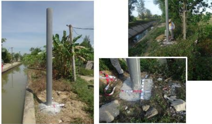
รูปที่ 1.6 การติดตั้งเสารองรับโดยใช้ท่อ PVC D250mm เป็นแบบหล่อในสถานที่ที่มีการถูกขโมยอย่างสูง
