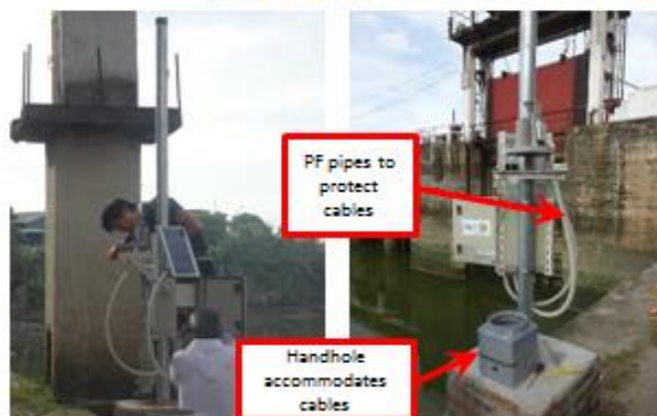
รูปที่ 1.7 การติดตั้งชั่วคราวกล่องควบคุม TM และแผงโซลาร์เซลล์และดูสำรวจ
