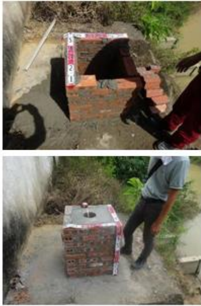
รูปที่ 1.4 การก่อสร้างฐานรากคอนกรีต
