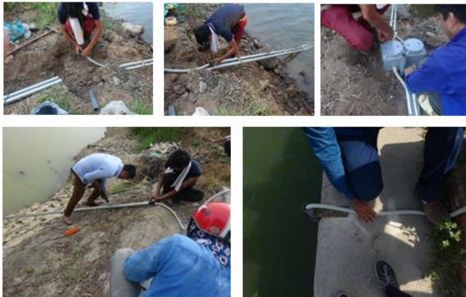
Hình 1.12. Bảo vệ cáp cảm biến mực nước bằng ống PF, lưu trữ cáp dư trong lỗ thăm dò
