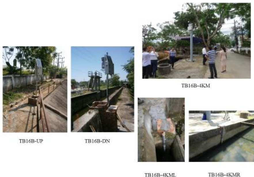
Hình 3.2 Thiết bị TM được cài đặt trong TB16B
