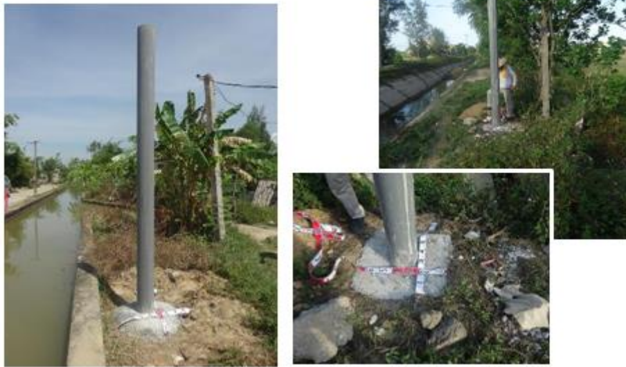
Hình 1.6 Lắp đặt trụ đỡ hỗ trợ sử dụng ống PVC D250mm làm ván khuôn ở những vị trí có nguy cơ trộm cắp cao
