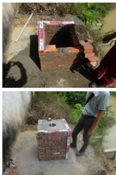
Hình 1.4. Thi công móng bê tông
