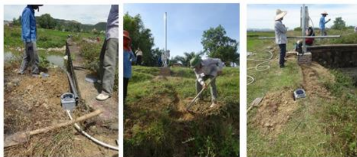
Hình 1.8. Lắp đặt cáp cảm biến mực nước
