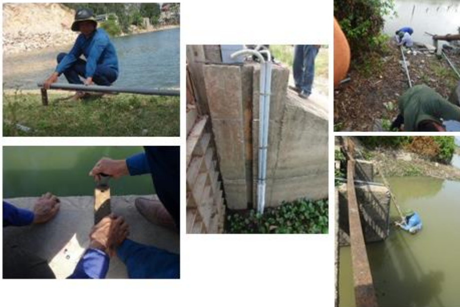
Hình 1.11. Lắp đặt ống dẫn và cảm biến mực nước
