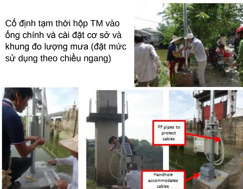
Hình 1.7. Lắp đặt tạm thời hộp điều khiển TM, bảng điều khiển năng lượng mặt trời và lỗ thăm dò Đường ống cảm biến và sắp xếp lỗ thăm dò và đào
