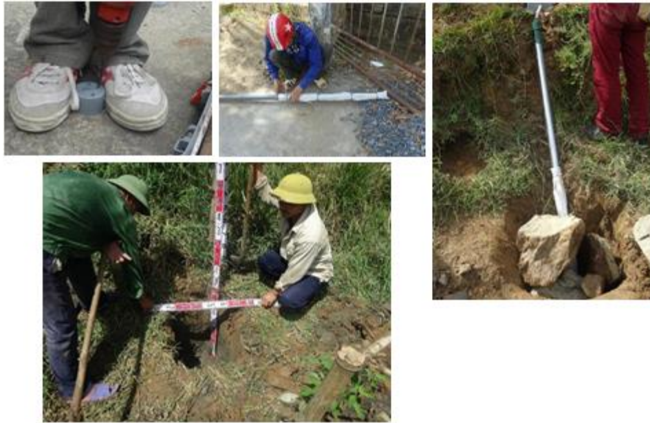
Figure 1.10. Ống dẫn hướng khoan cho cảm biến mực nước và bảo vệ phần khoan bằng vải không dệt
