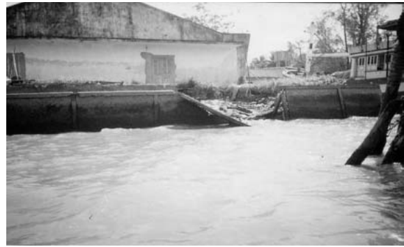
Hình 23: Tường cừ BT (sông Tiền - Tiền Giang) bị lún theo phương đứng.
