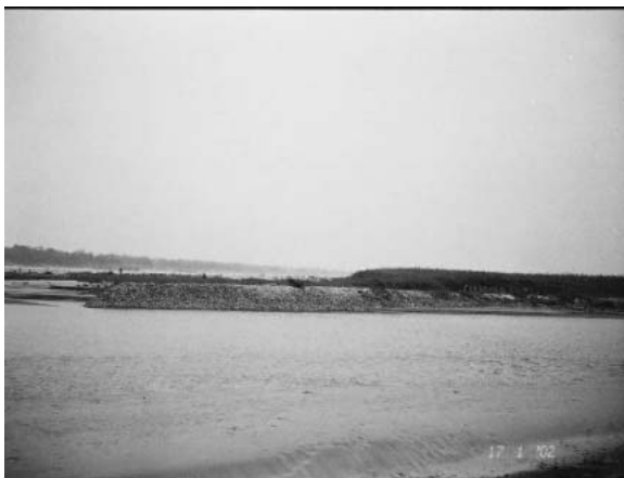
Hình 3: Mỏ hàn đón dòng đầu bãi Tứ Liên (sông Hồng) do cao trình đỉnh thấp nên gây bồi ở thượng lưu (lạch trái) và gây xói ở hạ lưu (lạch Quýt).
