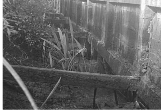
Hình 10: Kè bảo vệ bờ sông tại UBND huyện Mỏ Cày, sau hai năm hoàn thành, phần đất đắp trên kè bị lún, sụt do nước xói ngầm lấy đi (2006).
