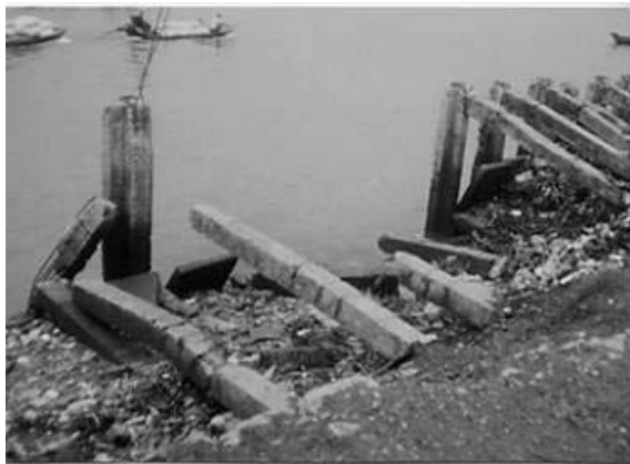
Hình 16: Khung BTCT - kè Vĩnh Long cũ -sông Tiền (1994).
