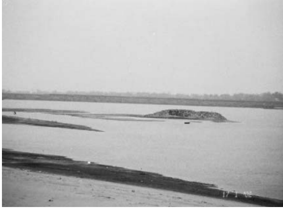
Hình 1: Mỏ hàn Phú Gia hình chữ K2 (sông Hồng) bị phá ngang gốc vì dòng lũ tràn qua đỉnh.
