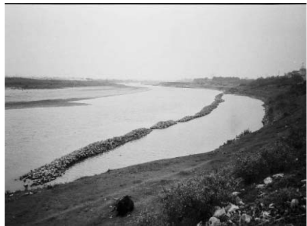
Hình 4: Đập dọc An Dương (sông Hồng) - điều chỉnh đường bờ và gây bồi - nhưng cao trình quá thấp không đạt hiệu quả như mong muốn.
