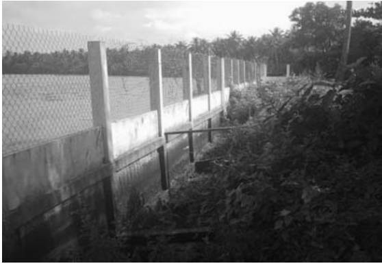
Hình 10: Kè bảo vệ bờ sông tại UBND huyện Mỏ Cày, sau hai năm hoàn thành, phần đất đắp trên kè bị lún, sụt do nước xói ngầm lấy đi (2006).
