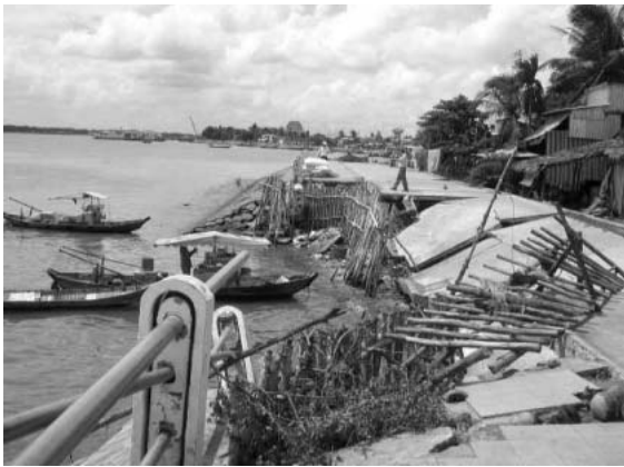
Hình 11: Mất ổn định cục bộ theo phương đứng do xói chân công trình kè Long Xuyên – An Giang (2005).
