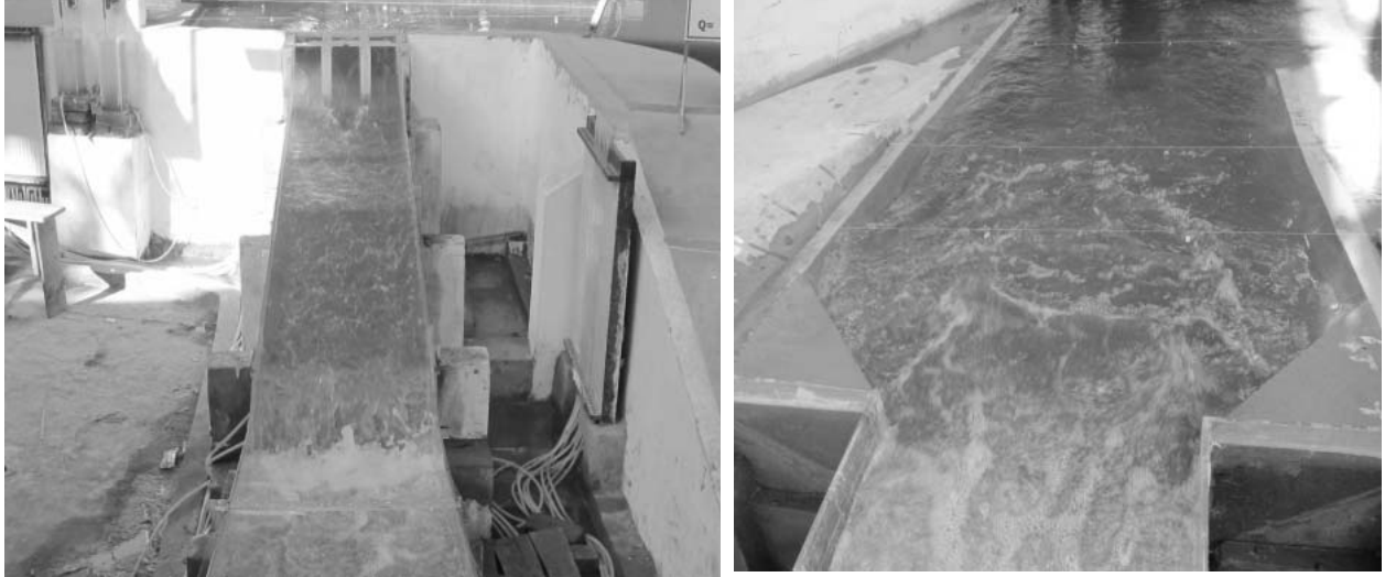
Hình 10. Tình hình thủy lực trên dốc nước, bể tiêu năng và đoạn cửa ra kênh hạ lưu
