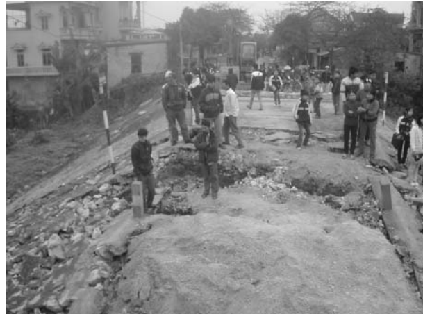
Hình 2. Sự cố lún, sụt nền và mang cống đập Phúc do xói ngầm
